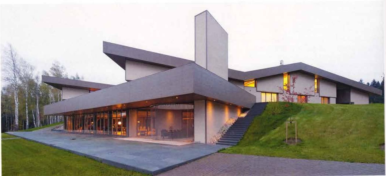
Große Fensterflächen und die dreieckigen Lufträume sind zwei der markanten Stilelemente des Wochenendhauses.
